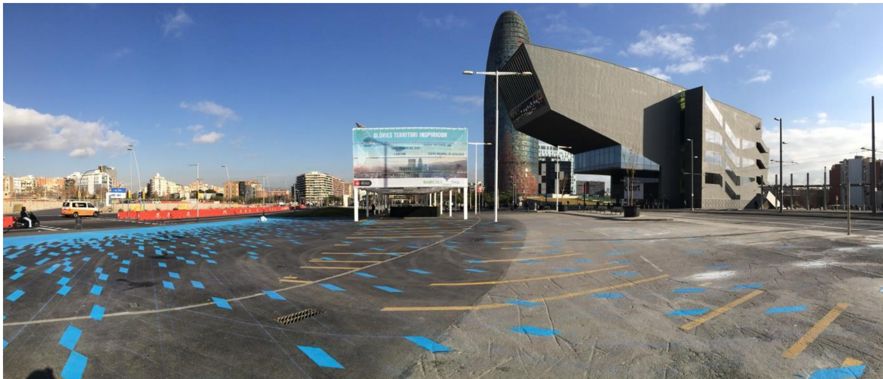
2015_ PROVISIONAL URBANIZATION PL DE LES GLÒRIES
